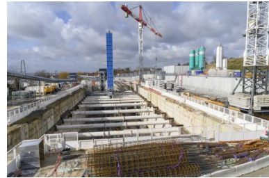
Le chantier du Grand Paris Express. Les professionnels et les salariés du BTP demandent l'arrêt des chantiers. © AFP
